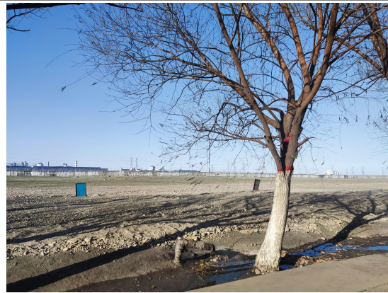
已拆除⑥硅锰水渣跳汰线
