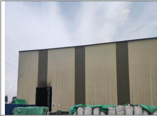
成品库 (3#全封闭料棚)
